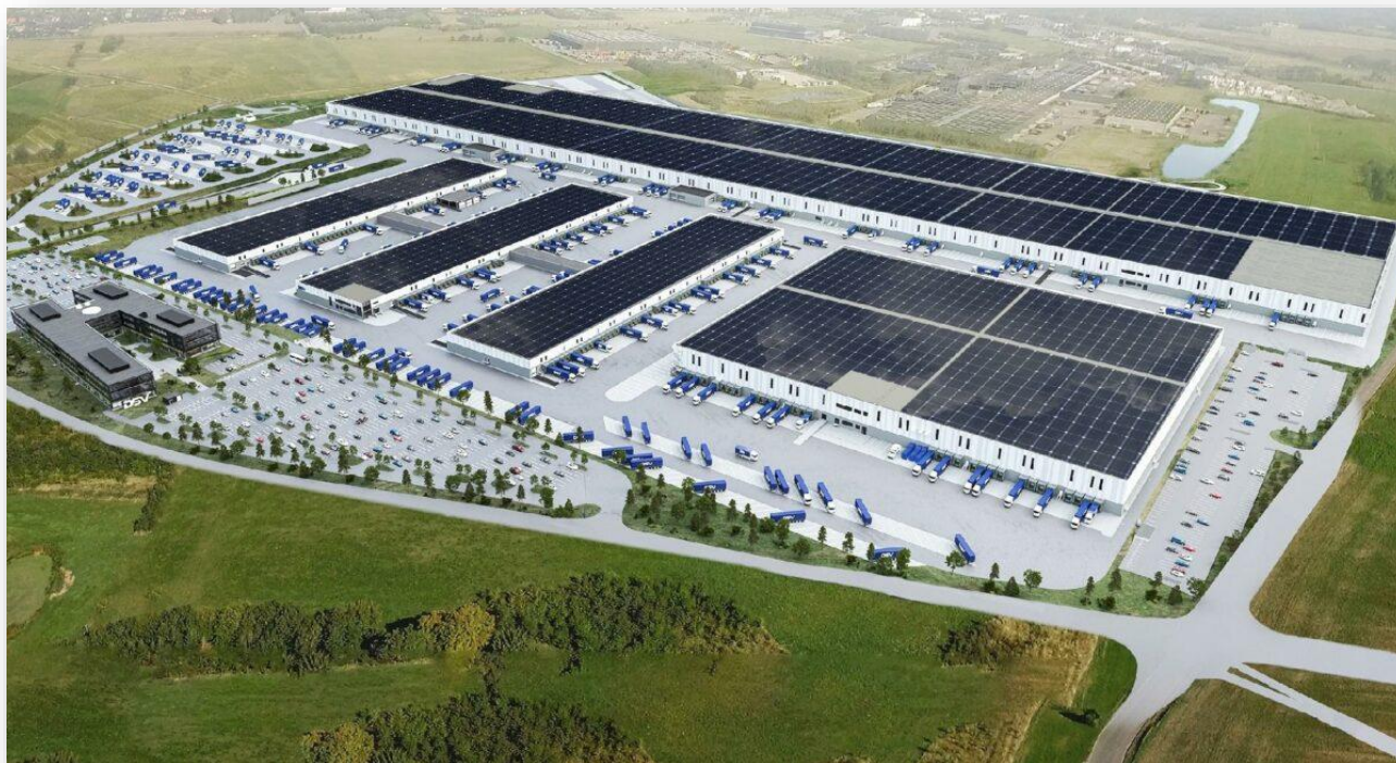
Verdens største tagplacerede solcelleanlæg på logistikvirksomhed ved Horsens
